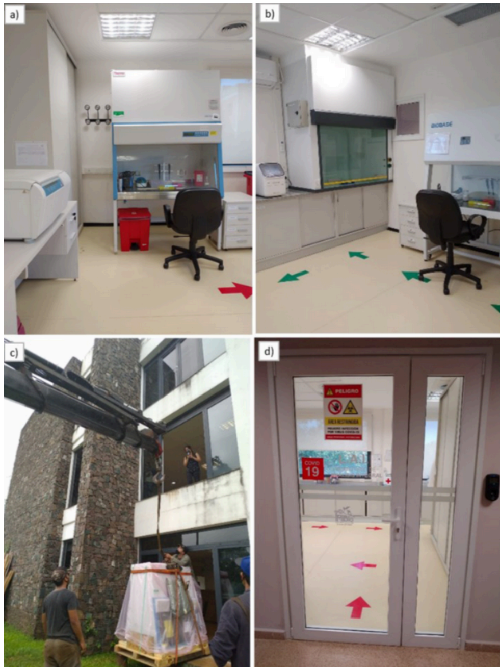
Figura 5: Adaptación y renovación del laboratorio. a) Sala sucia. b) Sala limpia. c) Traslado, montaje, izaje y posicionamiento de la cabina de seguridad biológica clase II. d) Señalización del laboratorio. Fuente: Kuhlmann PA et al (2022). Implementación de un laboratorio de nivel de bioseguridad 2 para diagnóstico molecular de SARS-CoV-2 en Puerto Iguazú, Misiones. Rev Argent Salud Pública.
